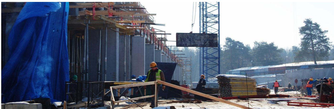
Budowa stadionu w Białymstoku Fot. MU-S
